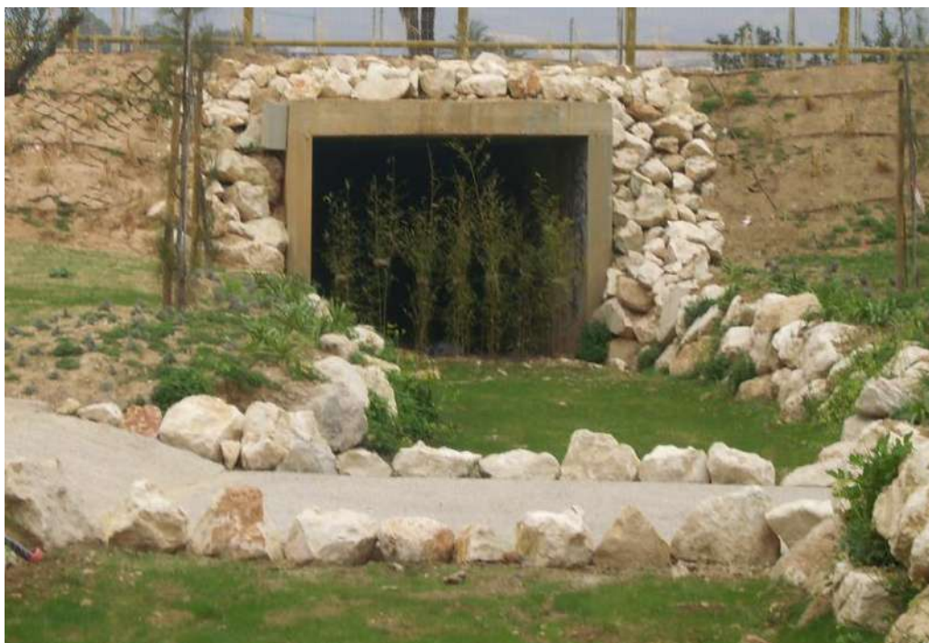
Imagen 61. Marco existente a mantener encauzamiento a barranco Barceló
