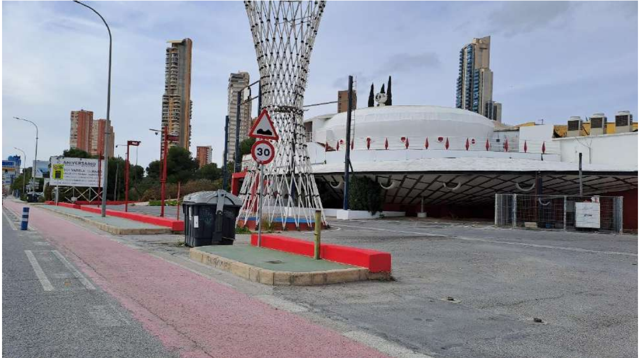
Imagen 59. Estado de discotecas Av. Comunidad Valenciana sentido Benidorm
