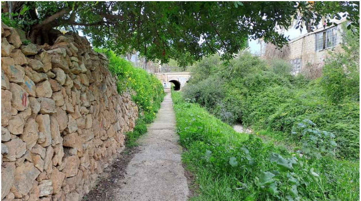
Imagen 56. Camino peatonal aguas abajo del puente que cruza la Av. de la comunidad Valenciana
