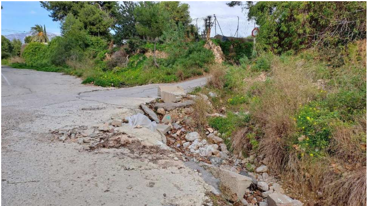
Imagen 52. Cruce de la calle Esperanto con la calle Derramador
