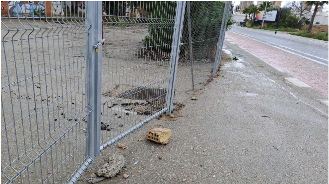
Imagen 6. Pozos de telecomunicaciones en la Av. de la Comunidad Valenciana
