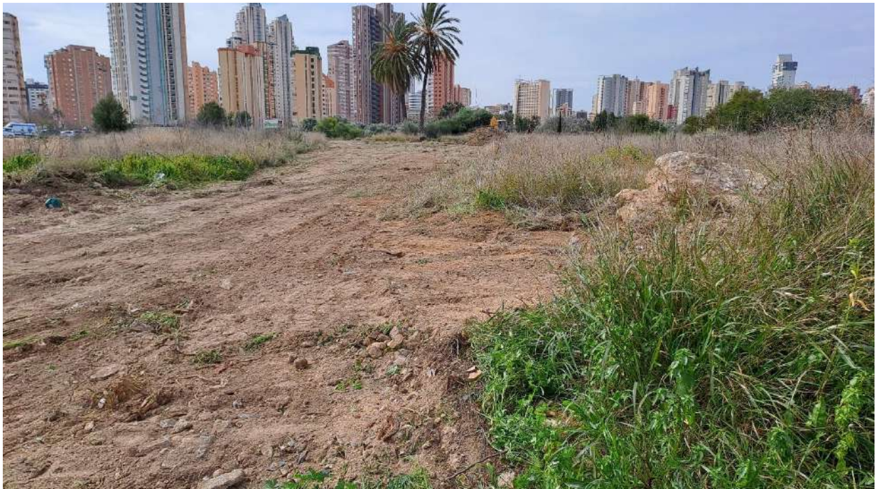
Imagen 28. Labores de desbroce en el interior del sector justo en la zona próxima a la Av. de Bernat de Sarria.
