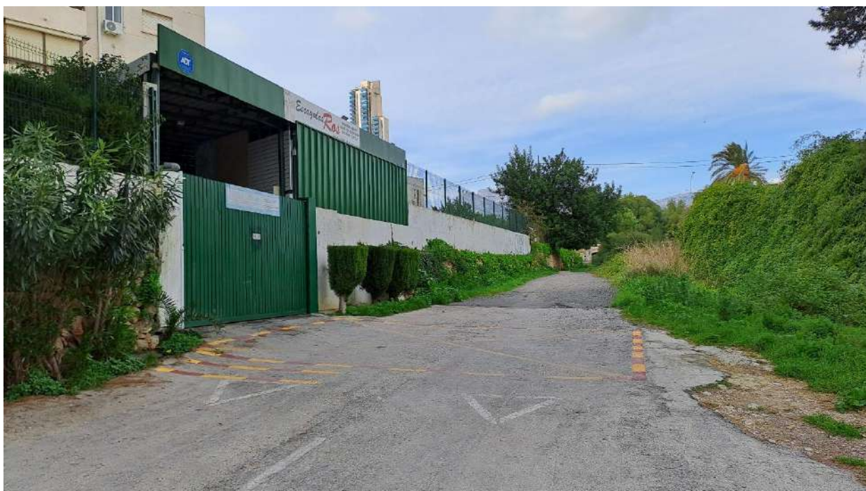
Imagen 54. Vado existente del edificio gemelos 10
