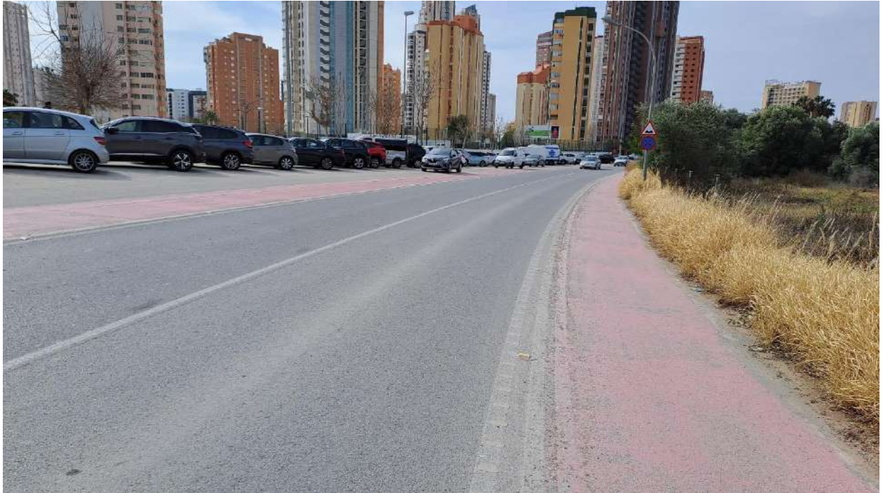
Imagen 35. Estado de la Av. de Bernat de Sarria sentido Benidorm
