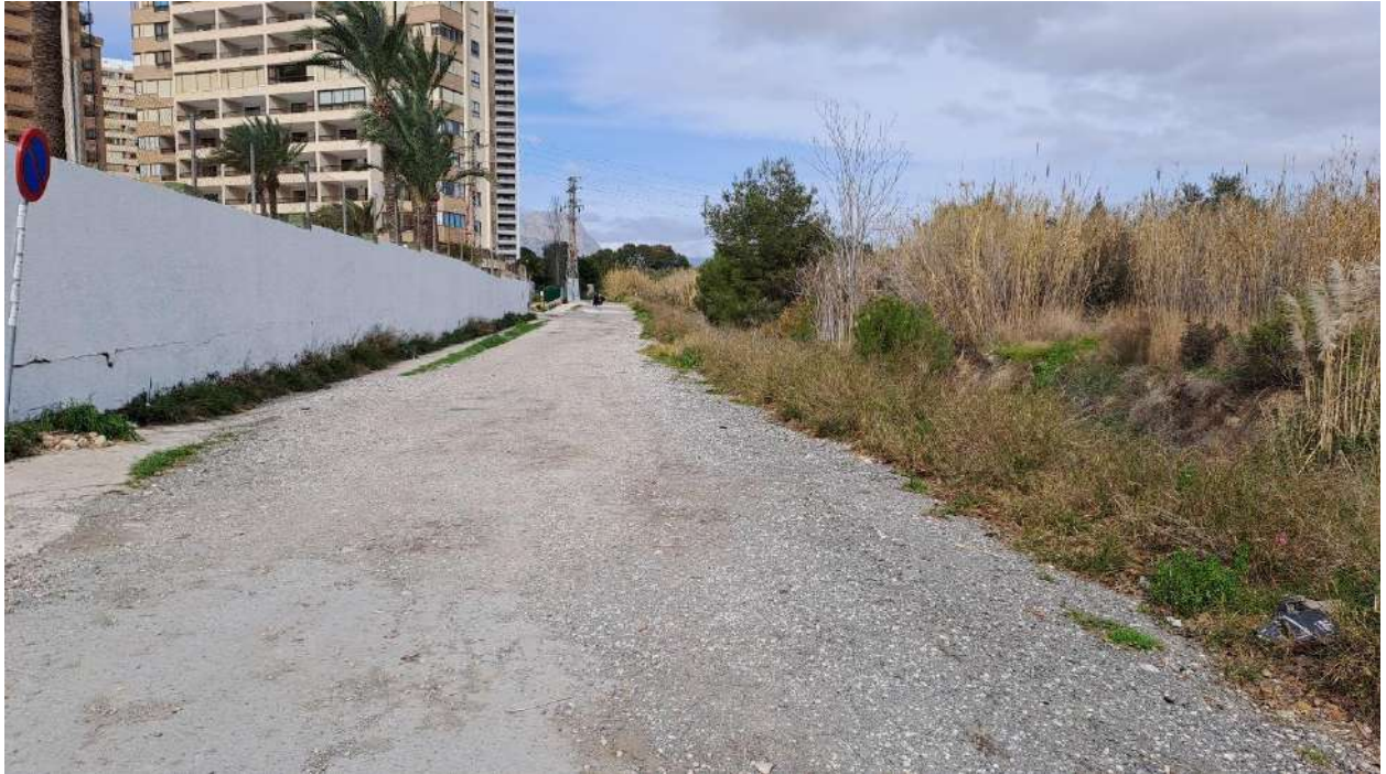
Imagen 47. Estado de la calle Derramador
