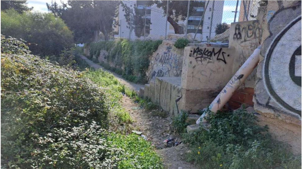
Imagen 5. Camino peatonal margen derecho del barranco que une la Av. Comunidad Valenciana con la calle Derramador
