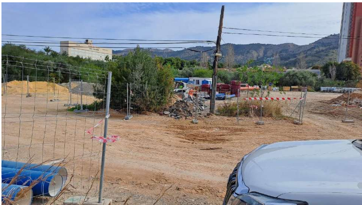
Imagen 31. Zona de acopio de obra próximas al sector. Posible zona de acopio de materiales.
