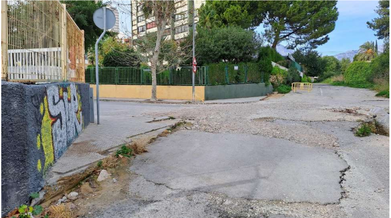
Imagen 51. Cruce de la calle Esperanto con la calle Derramador
