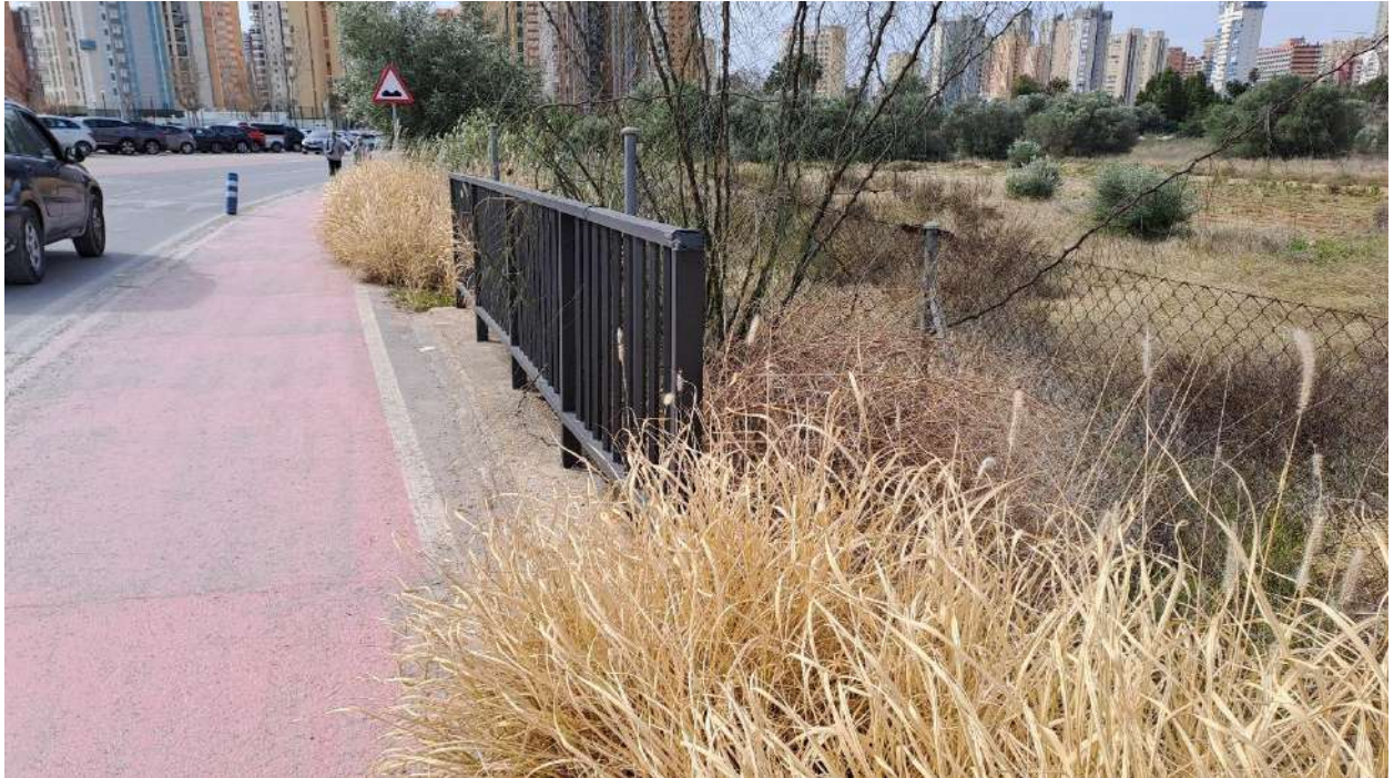
Imagen 33. Ubicación del encauzamiento existente que llega hasta el parque infantil próximo al sector
