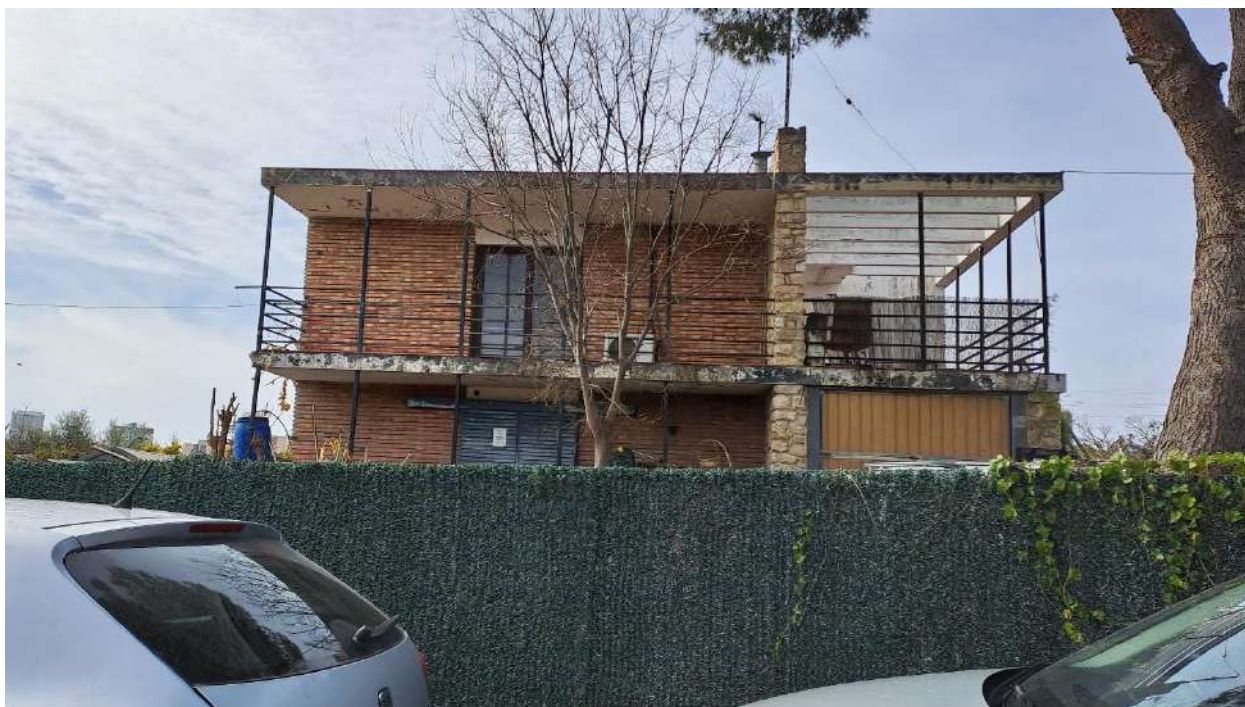
Imagen 19. Casas residenciales existentes a lo largo de la calle Armanello
