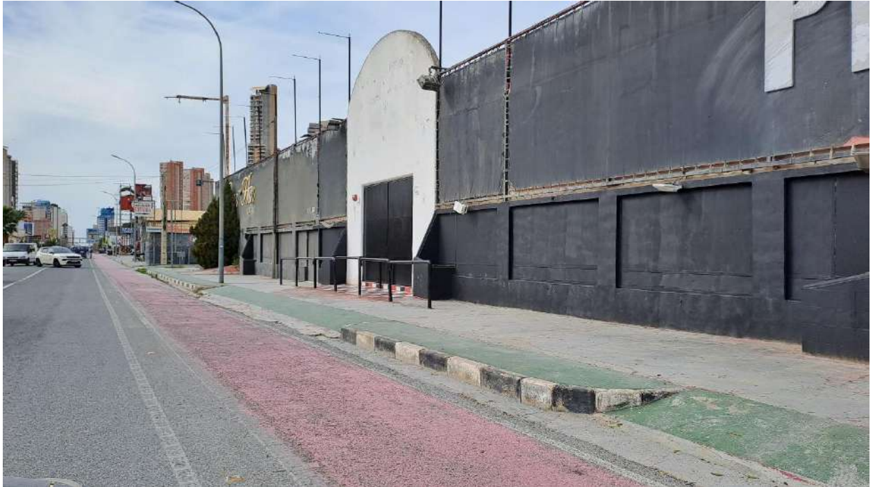
Imagen 57. Estado de discotecas Av. Comunidad Valenciana sentido Benidorm
