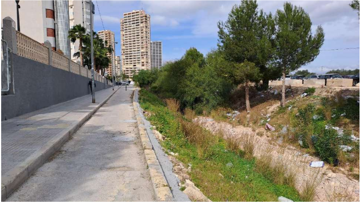
Imagen 41. Camino peatonal paralelo al barranco hasta existente cruce
